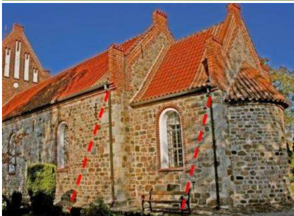
Figur 7. Værløse kirke. Apsis, kor og skib bygget 1130-1160. Farum Kirke bygget i 1130'erne. Begge kirker er bygget i marksten med hjørner af udhuggede kalk//frådsten. Siden er tage og vinduer ændrede, og tårn og våbenhuse tilbyggede.
